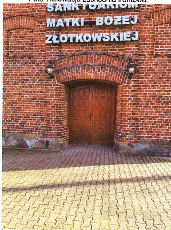
Foto 2. Elewacja zachodnia frontowa.
