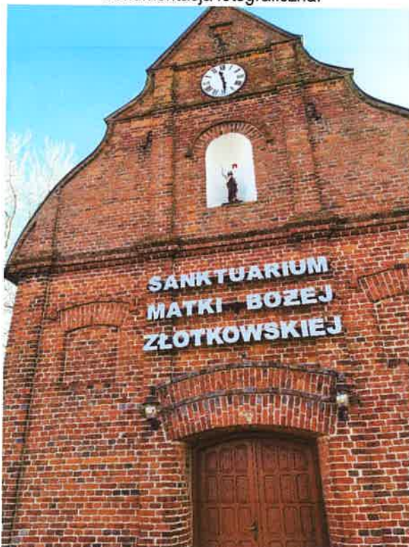
Foto 1. Elewacja zachodnia frontowa.
