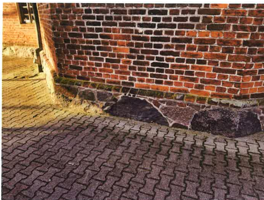
Foto 9. Elewacja wschodnia przyziemie.
